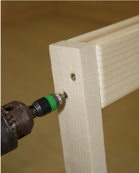
Transportleiste vom Türstock entfernen
