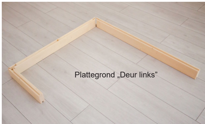
Afb. 1: Plaatsen van de drie bodemframe-elementen
