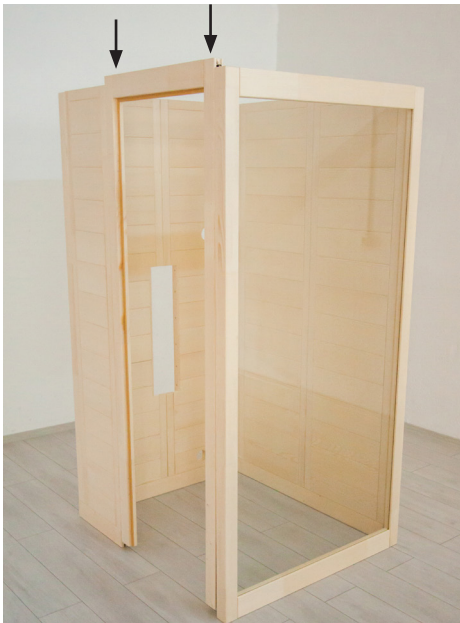
Abb. 10: Montage des Türrahmens
