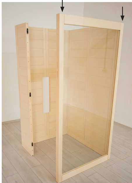
Fig. 10: Montaggio del telaio della porta
