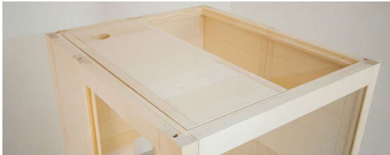
Abb. 14: Einlegen Dachelemente vorne
