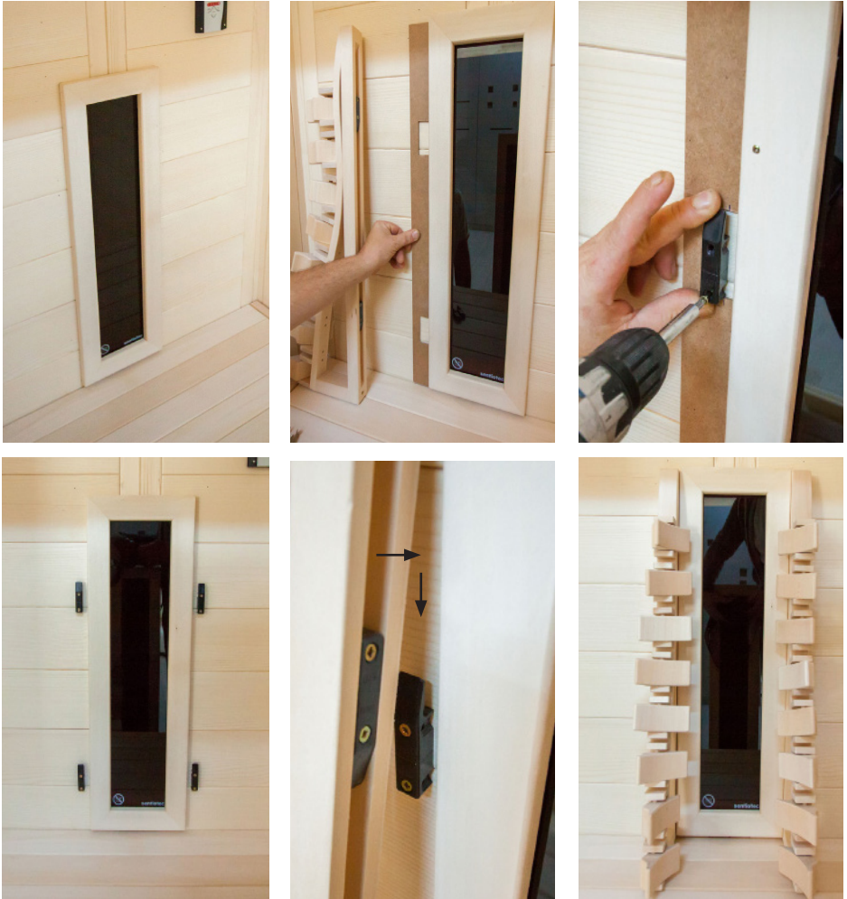
Fig. 29: Montagem dos encostos
