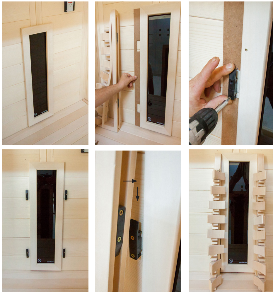
Fig. 29: Montaggio degli schienali
