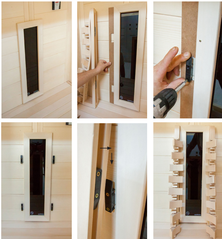
Abb. 29: Montage Rückenlehnen
