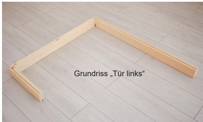
Abb. 1: Auflegen der drei Bodenrahmen-Elemente
