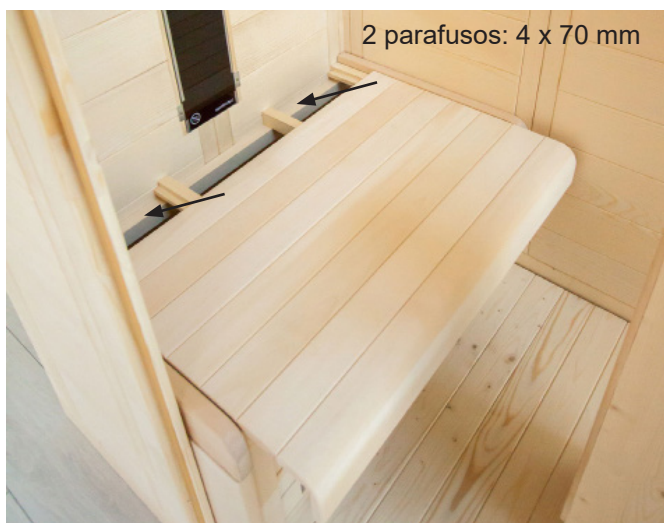
Fig. 27: Fixação do banco
