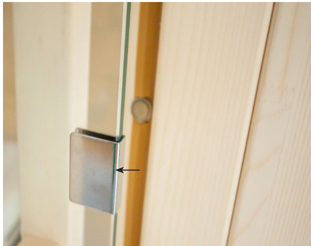
Afb. 35: Montage overschuifplaat
