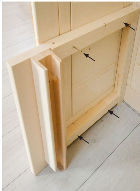
Abb. 18: Bankauflagen montieren
