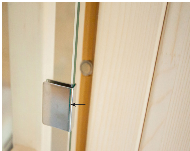
Fig. 35: Montaggio della piastra a scorrimento
