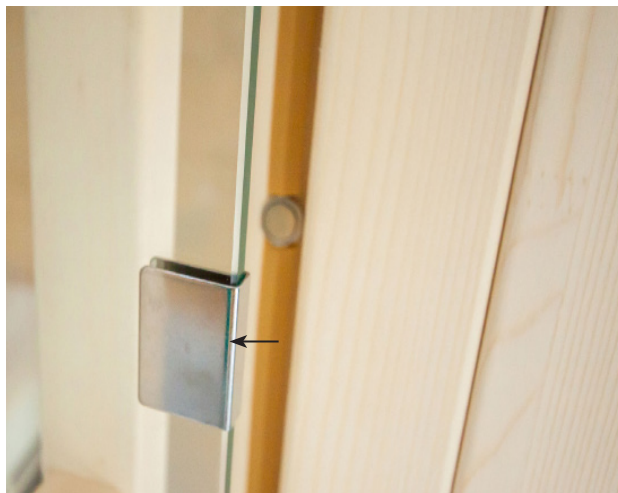
Fig. 35 : Montage de la tôle extérieure
