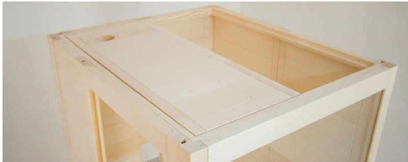
Fig. 14: Inserção dos elementos de teto da frente
